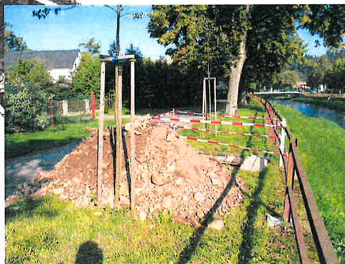
Pohled na výkopek z rubu zdi kopané sondy č.3
