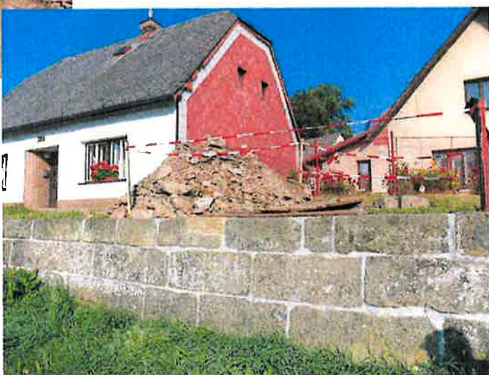
Pohled na výkopek z rubu zdi kopané sondy č.1
